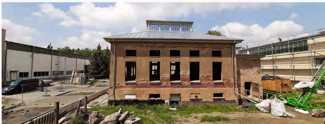
Pavillon der ehemaligen Spitzenfabrik in Plauen: Er wurde extra für eine Dampfmaschine errichtet, die Strom erzeugen sollte. Das Gebäude steht unter Denkmalschutz.
